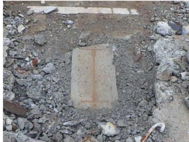
柱部材 (SRC造のコンクリート部、鉄骨部、柱脚部冷間切断(ワイヤーソー切断)部)
