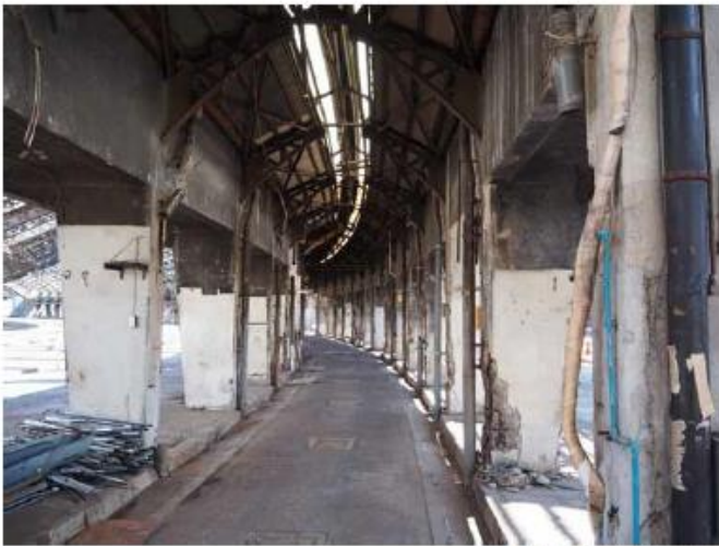
柱部材 (SRC造のコンクリート部、鉄骨部、柱脚部冷間切断(ワイヤーソー切断)部)
